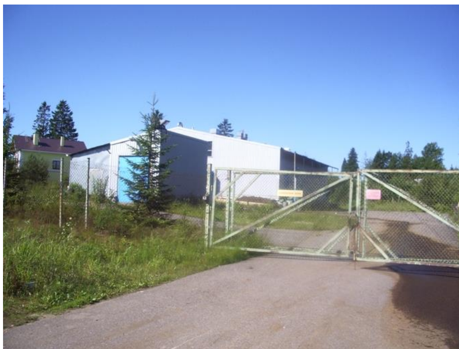
Рисунок 4.2.3.2 - Общий вид станции водоподготовки д. Агалатово (военный городок)
