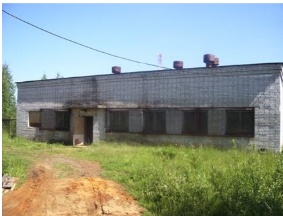
Рисунок 4.2.3.5 - Вид здания ВОС пос. Вартемяги
